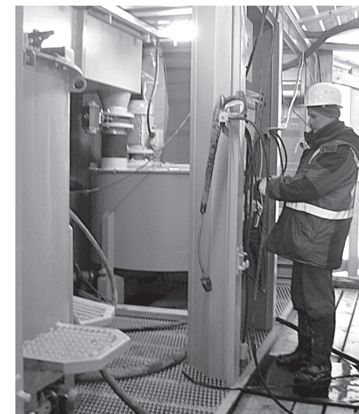
Рис. 4 Миксерная станция, установленная в тепляке, на объекте строительства метрополитена в г. Казани
