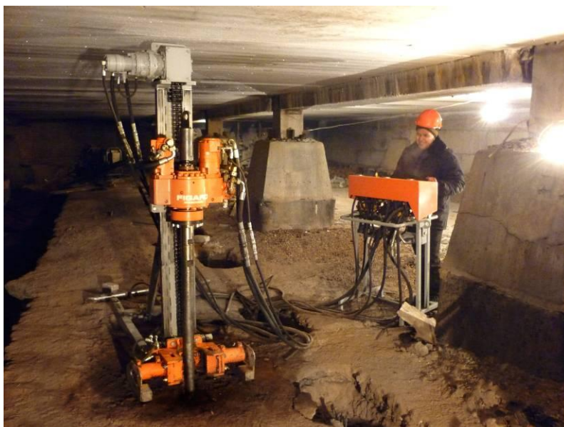
Рис.2. Производство работ в г. Набережные Челны
