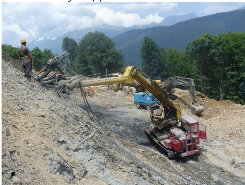
Рис.4. Установка нагелей Figaro Maschine
