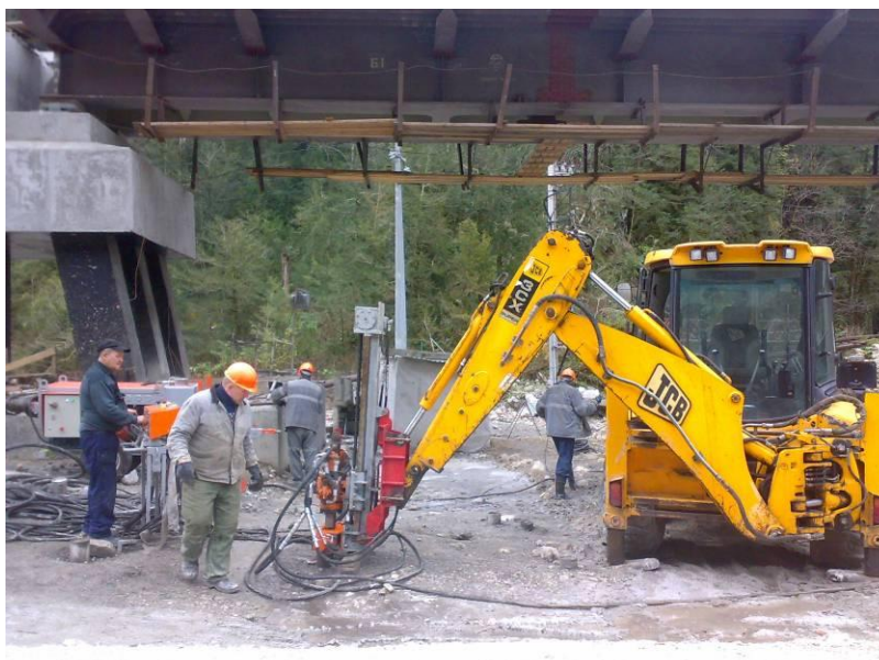
Рис.5. Figaro Maschine, установленный в качестве рабочего органа экскаватора
